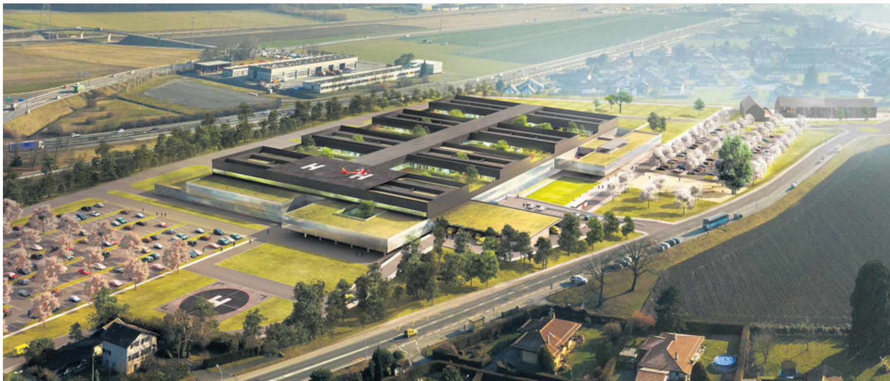
Le futur hôpital, sur trois niveaux, sera situé à un jet de pierre du village de Rennaz et de l'autoroute A9. IMAGE DE SYNTHÈSE; DR/GENINASCA DELEFORTRIE-GROUPE 6
