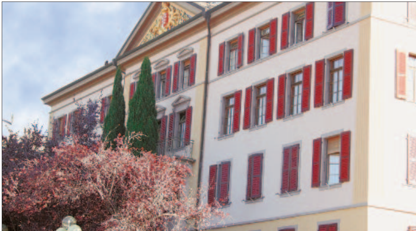
Der Kanton Wallis (hier das Regierungsgebäude in Sitten) investiert wie nie zuvor: 2010 sind es 220 Mio. Franken netto.
